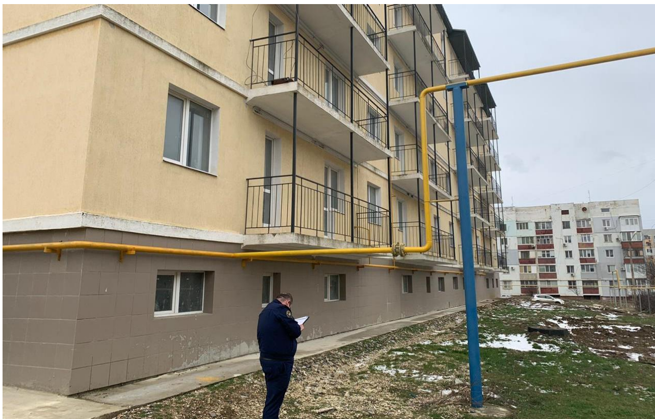
Рисунок 6. Осмотр возведенного дома
